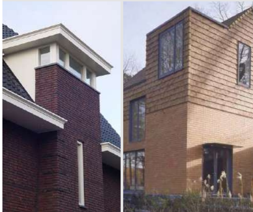
Referentie relatie hoofd- en aanbouw (n.b.: geen referentie m.b.t. ontbrekende dakoverstek)
