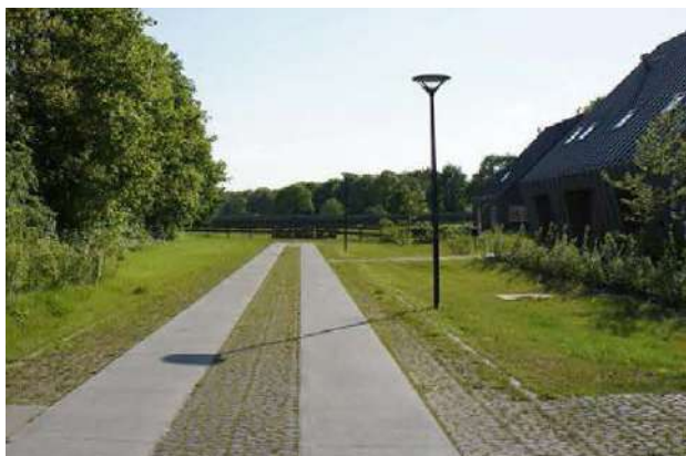
Karrenspoor met betonplaten
